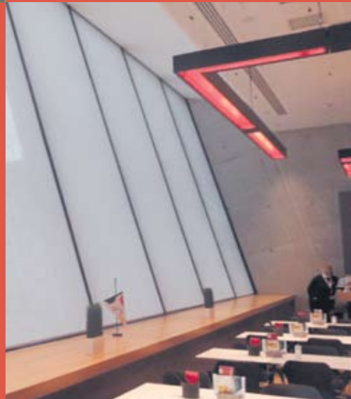
Das N11 Bar & Restaurant mit seinen extrem geneigten, sehr großzügigen Fensterflächen wurde mit einem entsprechend geneigten Sonnenschutzsystem ausgestattet. Foto: Brichta GmbH
