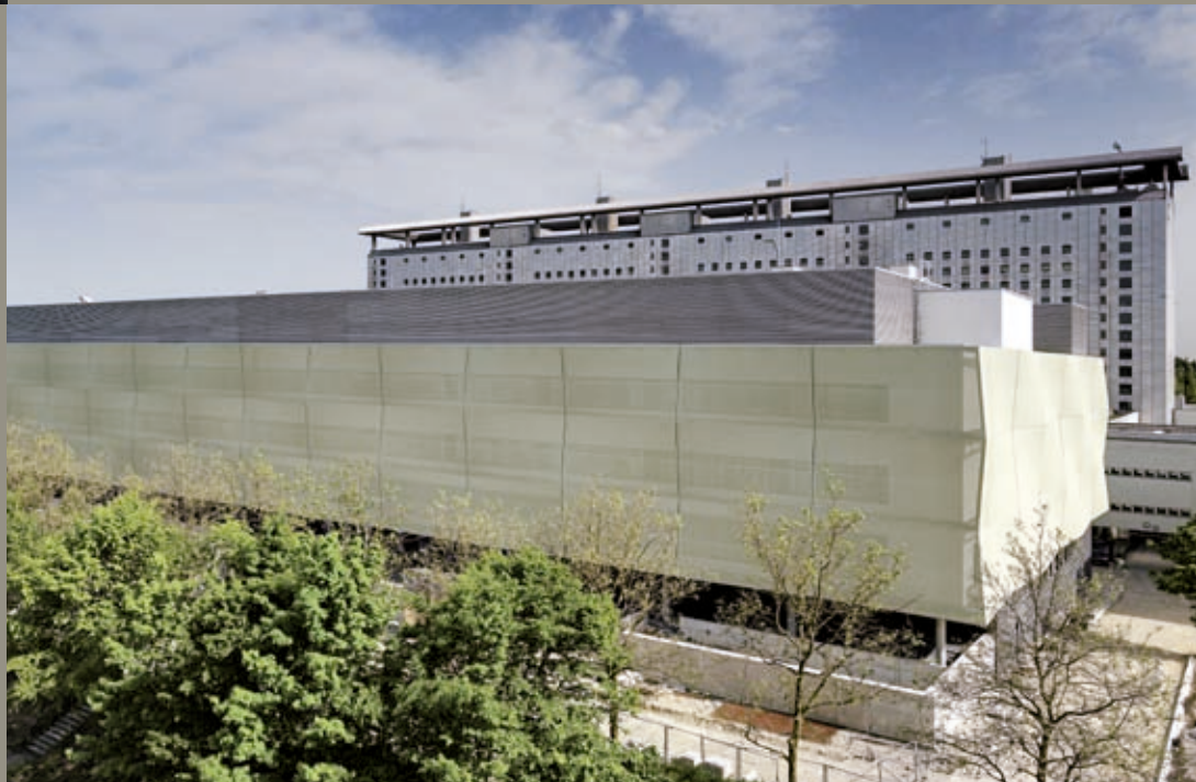
Das OP-Zentrum am Klinikum Großhadern der Universität München wird von der multifunktionalen flexiblen Textilfassade FACID umhüllt, die zugleich als Sicht- und Sonnenschutz fungiert. Foto: Mark Wohlrab
