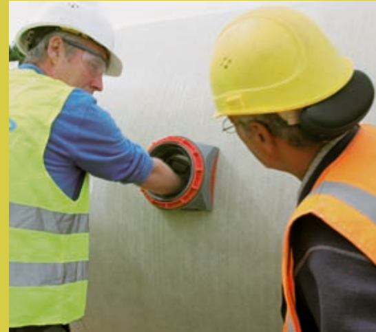
Ob Kunststoff, Beton oder Steinzeug: Der Anschluss kann bei unterschiedlichen Werkstoffen eingesetzt werden, unabhängig von Rohrrinnendurchmesser und Rohrwanddicke.
