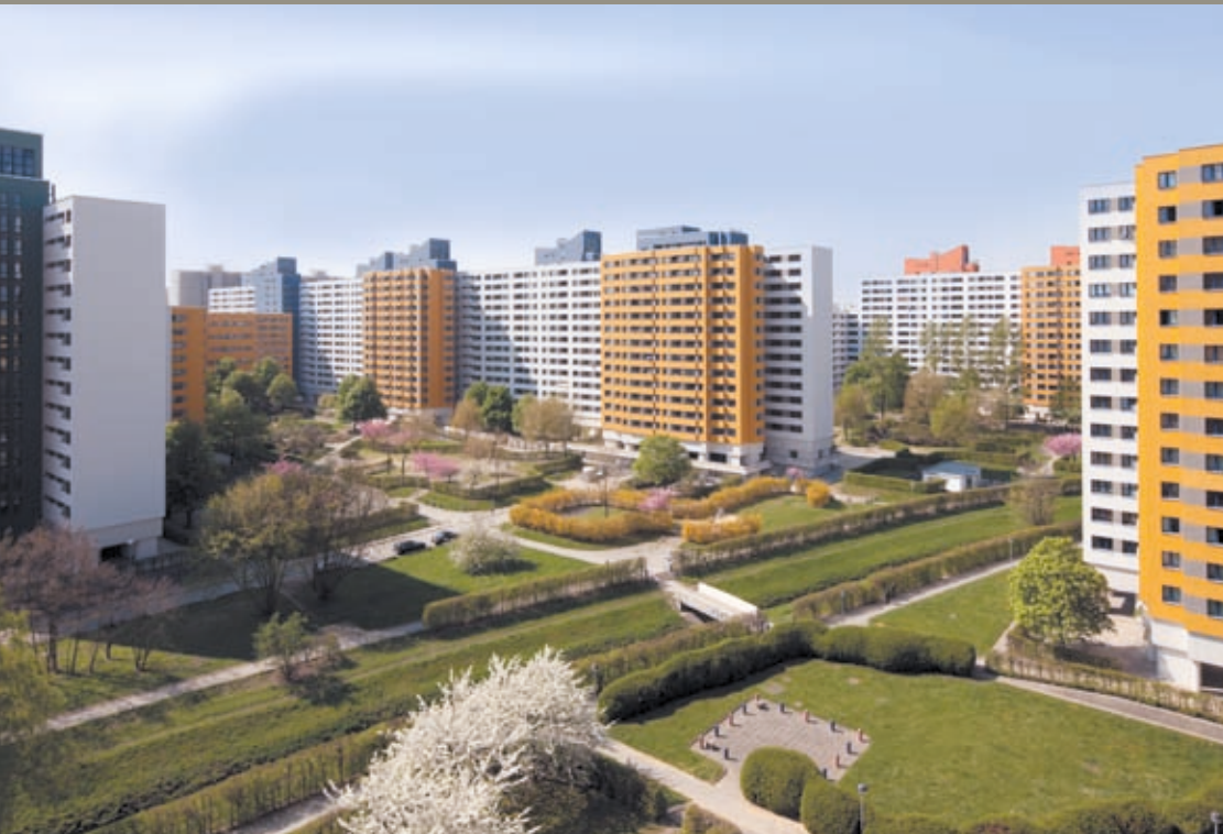
Nach der energetischen Sanierung, die beim Märkischen Viertel in Berlin auch den Einbau doppelt verglaster Kunststoffenster umfasste, bleiben die Mieten in etwa auf dem Niveau von früher. Foto: GESOBAU AG / Thomas Bruns
