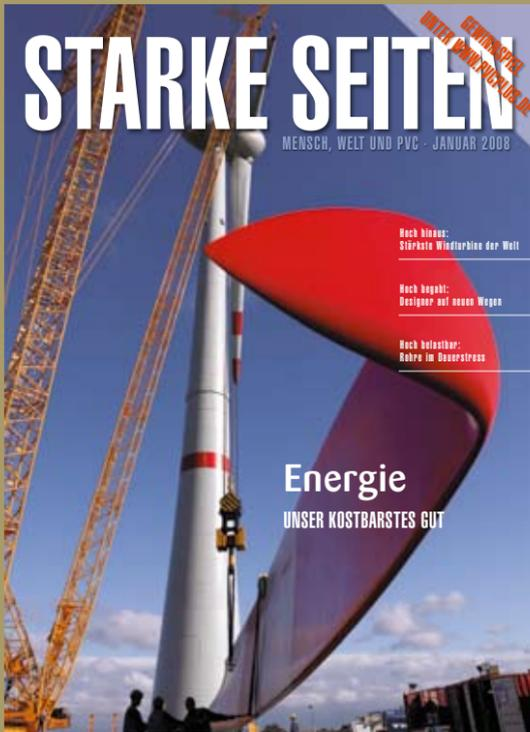
Ende 2007 hat Enercon die weltweit leistungsstärkste Windturbine E-126 aufgestellt. Damit die Rotorblätter stabil und widerstandsfähig sind, wurden sie erstmals mit vernetztem PVC-Schaum hergestellt. Heute sind viele dieser Windräder in ganz Deutschland in Betrieb.
