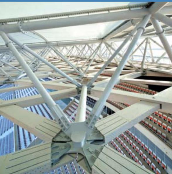
Blick von oben auf die Zuschauerränge der Arena in Nizza mit der Stahlkonstruktion, die das Stadionsdach trägt.
