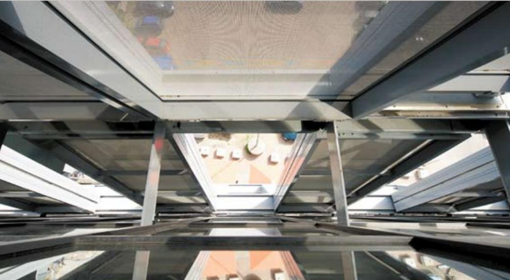
Die Befestigung der Sonnenschutzanlage an der Fassade des KaiSpeichers erfolgte mit Hilfe einer Konstruktion aus Stahlschwerern und Riegelprofilen.
