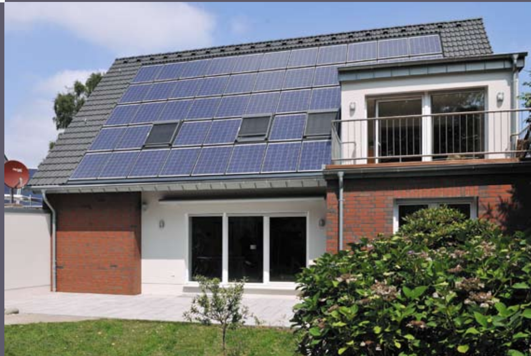
Dieses Einfamilienhaus aus dem Jahr 1962 wurde grundlegend energetisch saniert. Neben der Dämmung der Gebäudehülle gehörte auch der Einbau von Kunststoff-Fenstern im Passivhausstandard dazu.
