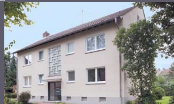
Vor der energetischen Modernisierung: Dieses Mehrfamilienhaus in Bottrop aus dem Jahr 1963 wurde zu dem oben links abgebildeten Energie-Plus-Haus umgebaut.
