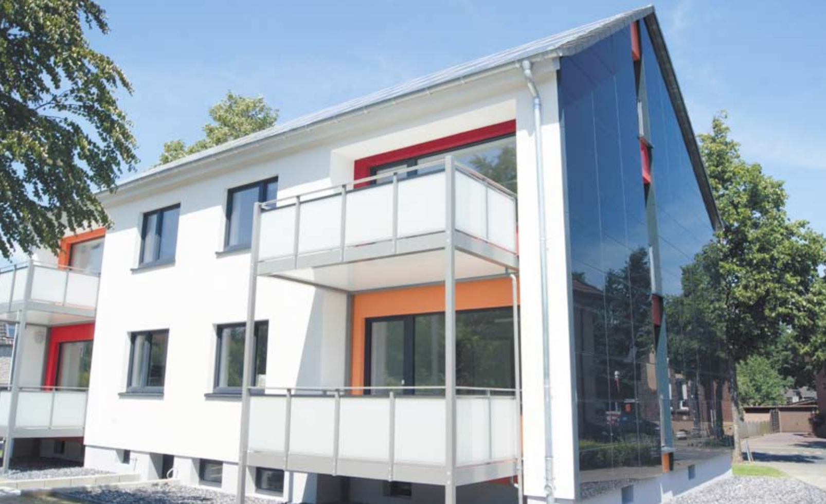
Modern und technisch auf dem neuesten Stand. Das VIVAWEST-Zukunftshaus nach umfangreichen Modernisierungsarbeiten.
