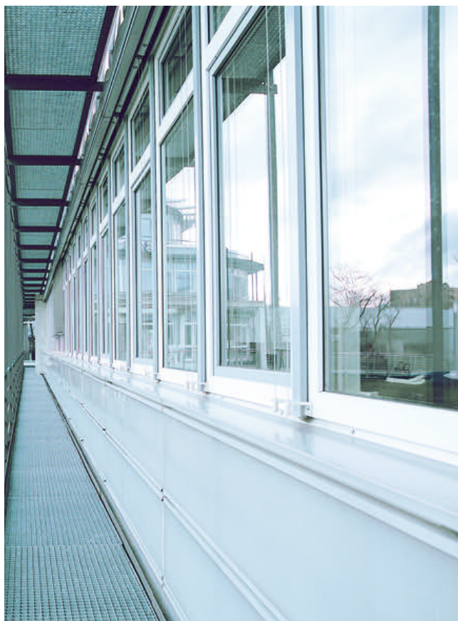
PVC-Fenster gibt es in weiß, wie hier in einem Firmengebäude, aber auch in verschiedenen Dekoren, z.B. Holzfarben (Foto: Baerlocher)
